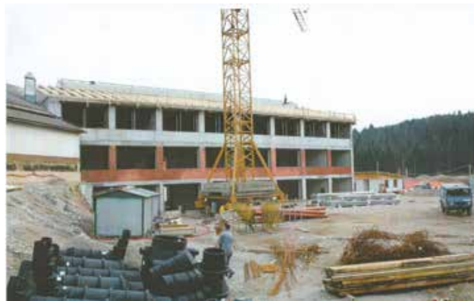
Gradnja prizidka (© arhiv šole)
